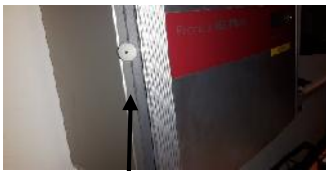
DC Trennschalter im Gehäuse
